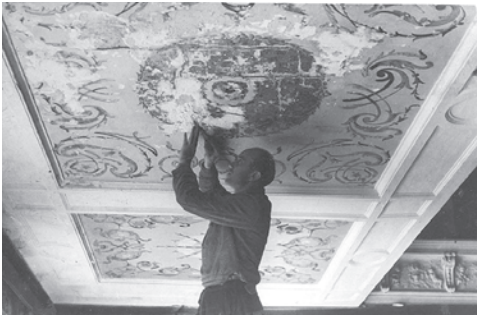
Парадный зал. Кессоны южной стороны. Художник-реставратор С.В. Коненков за работой по удалению разрушенной гипсовой накывки. ПДМП 1526 фд
