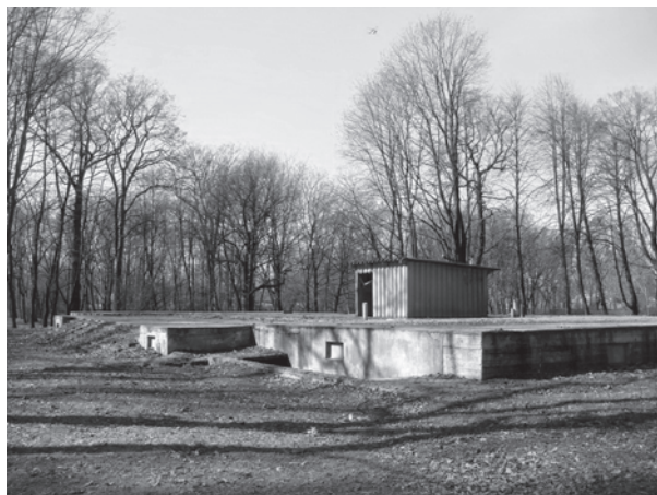
Бетонная оболочка над фундаментами Екатерингофского дворца. 2010
