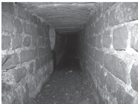
Кирпичный коллектор со стороны паркового фасада. 2009
