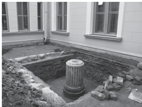
Вскрытый приямок мраморного фонтана. Восточный фасад дворца. 2007
