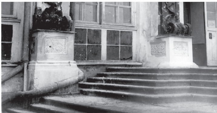
Пирамидальная лестница со стороны дворового фасада. Фрагмент. 1940
