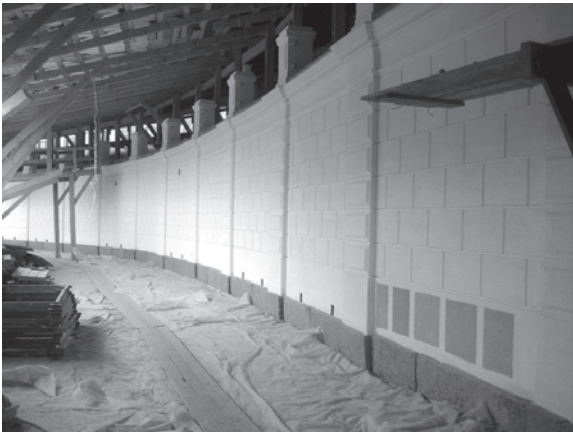
Завершенная реставрацией подпорная стенка террасы Большого дворца. Ораниенбаум. 2007. Видны пробные выкраски
