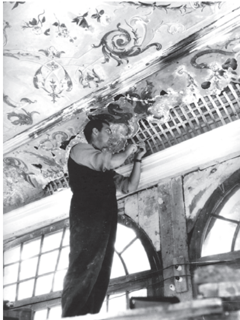
Замена подшивки и дранки на плафоне западной галереи. Художник-реставратор О.К. Оде. Июнь 1959. ПДМП 1287 фд
