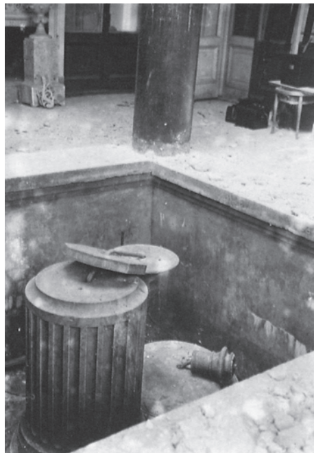
Общий вид приямка фонтана. 1920-е. Видны мраморная каннелированная колонна, сброшенная и опрокинутая ваза фонтана, фигурная подставка вазы, восьмигранная основа и деформированная медная водоводная трубка
