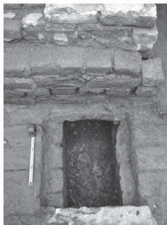
Выход в кирпичный коллектор со стороны паркового фасада. 2009
