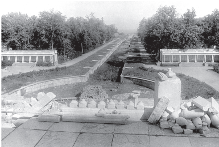
Большой Каскад в Петергофе. Разрушения. 1944. КГИОП
